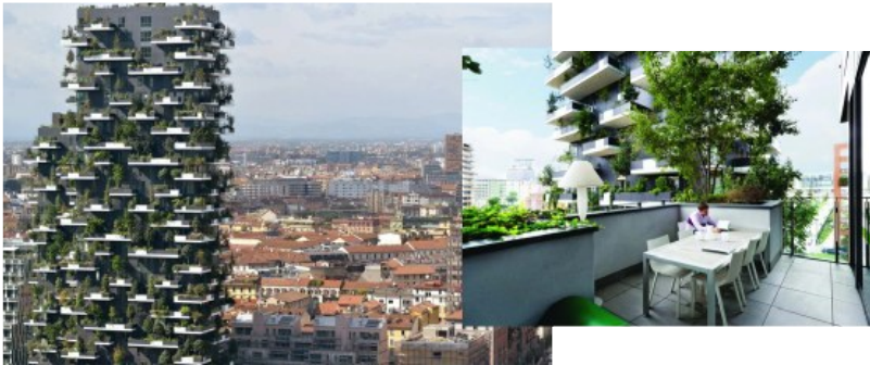
图5 米兰“垂直森林”投入使用后的室内外观
